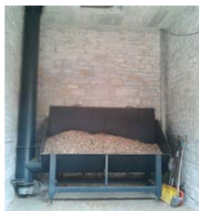
Caricatore di cippato a coclee per silo fuori terra
