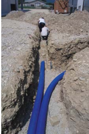
Posa di una minirete di teleriscaldamento
