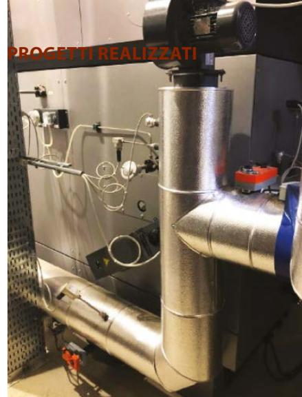
Generatore di vapore a biomasse Viessmann Vitoflex 300 FSB, a destra particolare del sistema di ricircolo
