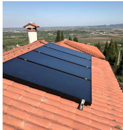
*I 4 pannelli solari termici oggi installati nei mesi estivi soddisfano totalmente il fabbisogno di acqua calda sanitaria, mentre durante l'inverno la loro attività è integrata con la caldaia a pellet*
