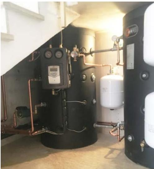
*Tutto l'impianto ha previsto l'installazione di un accumulo inerziale da 500 litri che funziona in sinergia con la caldaia a pellet e l'impianto solare termico*
