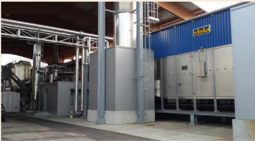
L'impianto di cogenerazione installato presso La Tiesse alimentato con biomasse agro-forestali e residui dell'industria della lavorazione del legno vergine
