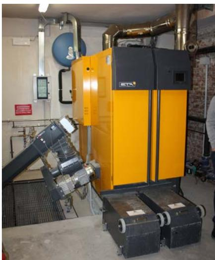
*All'azienda agricola La Pineta le caldaie a gasolio per il riscaldamento di tre unità abitative sono state sostituite da un nuovo impianto centralizzato a cippato che viene depositato in un locale interrato*
