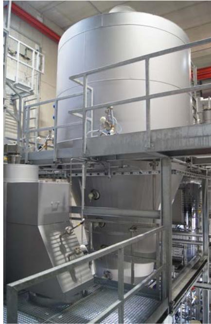
*L'impianto di gassificazione a cippato in funzione a Innsbruck vanta una tecnologia particolarmente innovativa. Molto affidabile, ha una potenza elettrica di 300 kW, mentre quella termica è di 488 kW. È entrato in funzione nel mese di novembre dello scorso anno*
