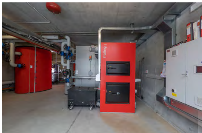
La caldaia Fröling TM500
