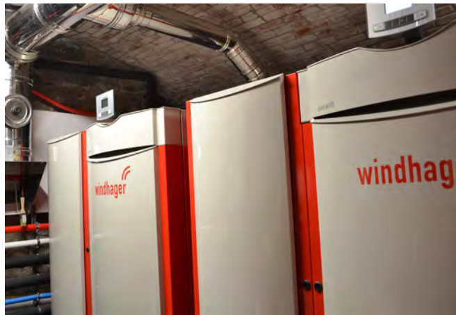
Le due caldaie Biowin XL600 in cascata
