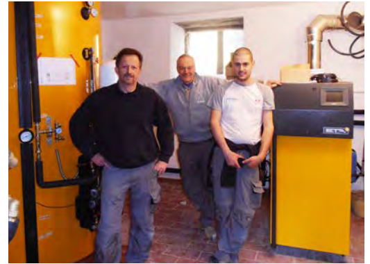
L'impianto con la caldaia e lo scambiatore di calore per la produzione di acqua calda. Da sinistra gli installatori dell'impianto: Walter Bizzarri e Stefano Del Sei con, a destra, il loro collaboratore Michael Bragalli
