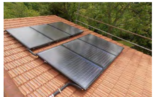
La realizzazione dell'impianto ha previsto anche l'installazione di pannelli solari
