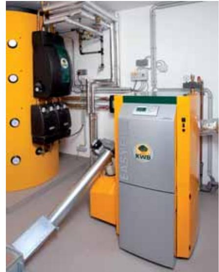
Il modello di caldaia a pellet KWB Easyfire con tecnologia innovativa Clean Efficiency presentato alla Mitteleuropäische Biomassekonferenz 2011 a Graz (Austria). Grazie ad una serie di misure primarie innovative e a un separatore di polveri incorporato nello scambiatore, raggiunge un rendimento del 96% e un fattore di PM di 4 mg/Nm<sup>3</sup>.
